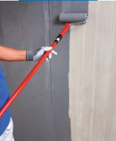
Aanbrengen van Eco Prim Grip op beton met een roller
