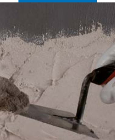
Aanbrengen van pleisterwerk op Eco Prim Grip
