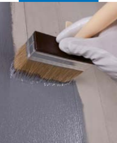
Aanbrengen van Eco Prim Grip op beton met een kwast
